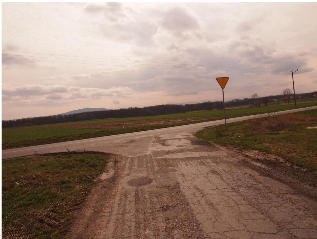
Widok na skrzyżowanie z DP2001D
