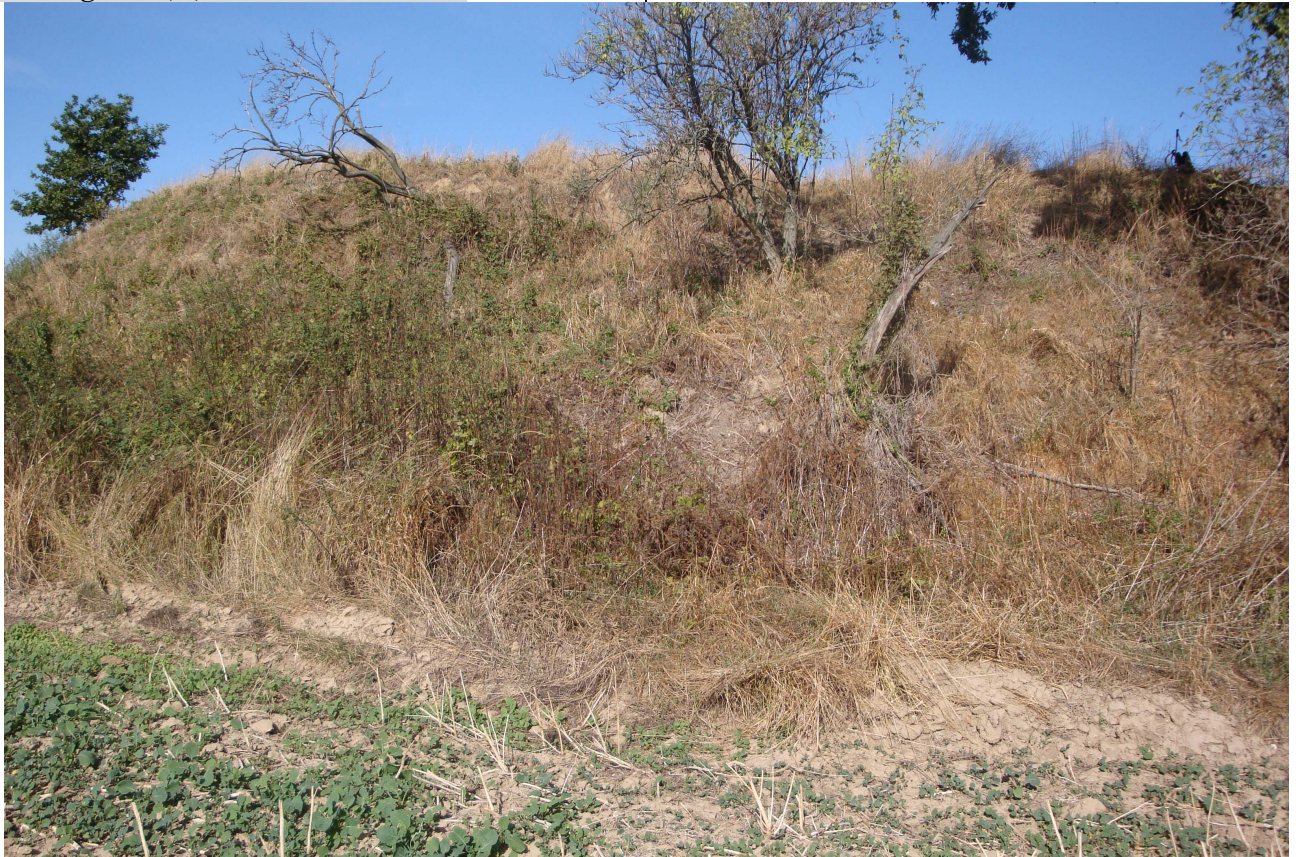
Widok ogólny od SE na świeży zsuw.
