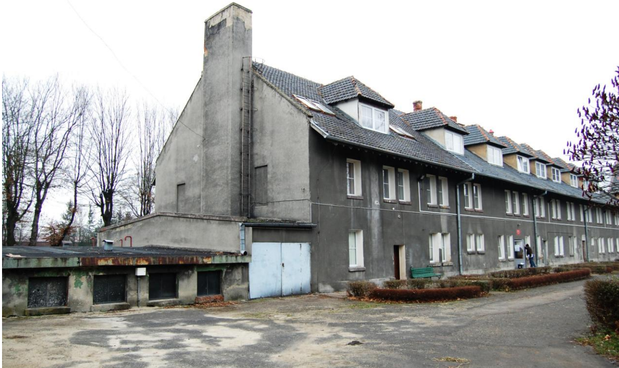
Obiekt nr 2 – internat + kotłownia lokalna (aktualnie węzeł ciepły)
