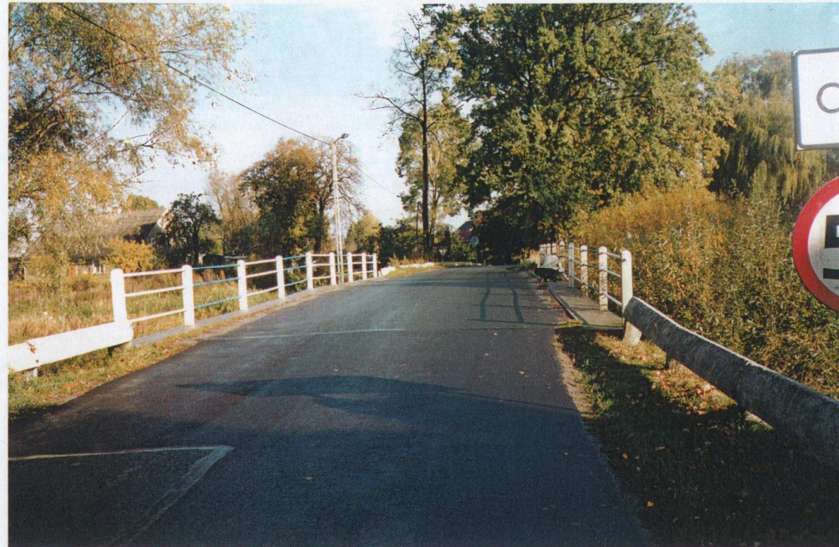
Fot. nr 1 Widok w kierunku Chrzóstawy Wielkiej – północnym
