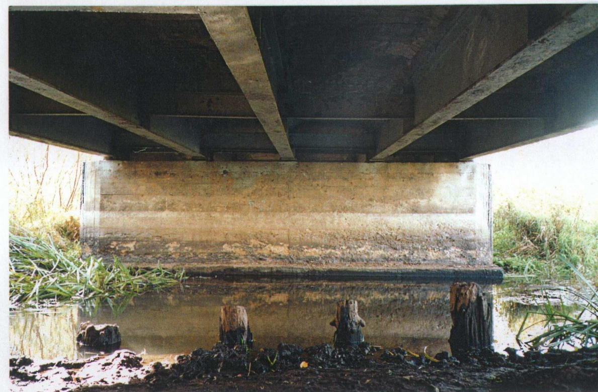
Fot. nr 3 Widok na filar w kierunku południowym
