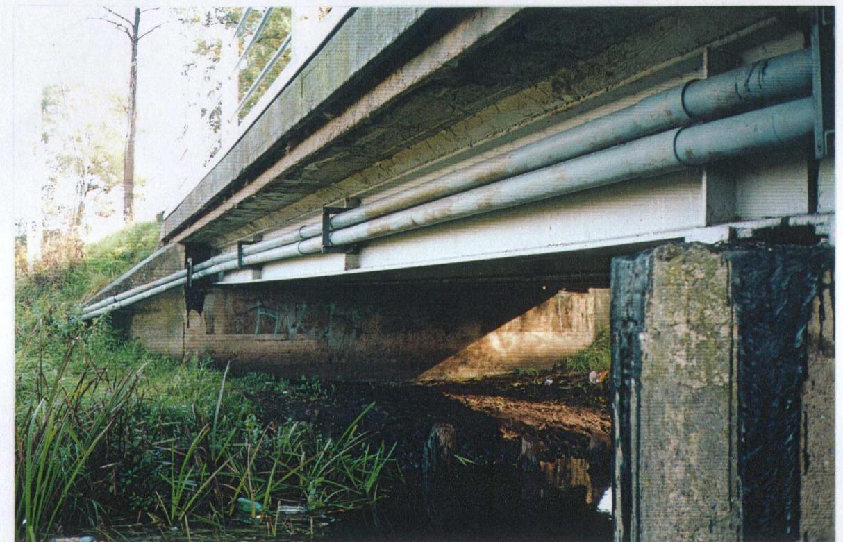
Fot. nr 4 Widok w kierunku przyczółka prawobrzeżnego (północnego)
