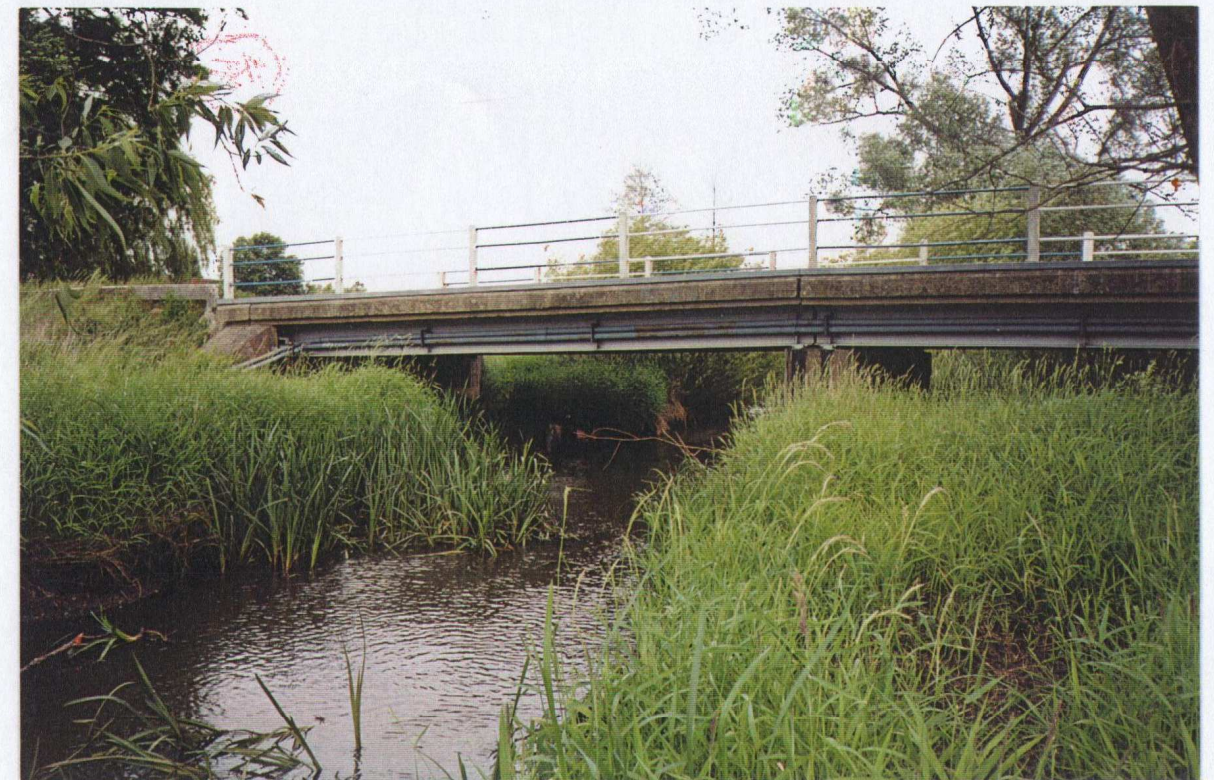
Fot. nr 2 Widok obiektu od strony dolnej wody – zachodniej
