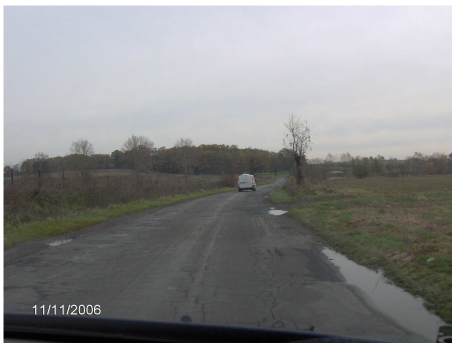
Zdjęcie nr 6 – widok w rejonie istniejącego przebiegu drogi powiatowej nr 1453D za m. Łozina
