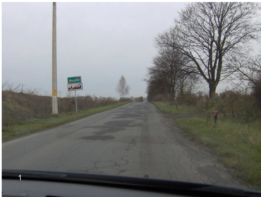
Zdjęcie nr 12 – – widok w rejonie istniejącego przebiegu drogi powiatowej nr 1453D w kierunku granicy Powiatu
