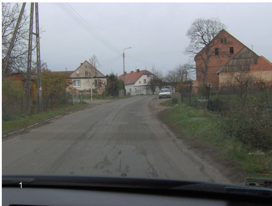
Zdjęcie nr 10 – widok w rejonie istniejącego przebiegu drogi powiatowej nr 1453D w m. Węgrów
