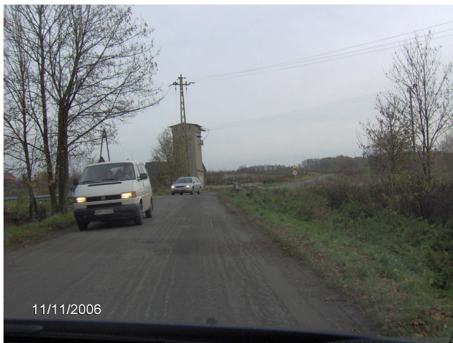
Zdjęcie nr 5 – widok w rejonie istniejącego przebiegu drogi powiatowej nr 1453D za m. Łozina
