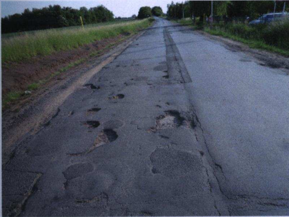
Fot. Z1. Widok drogi w kierunku A4
