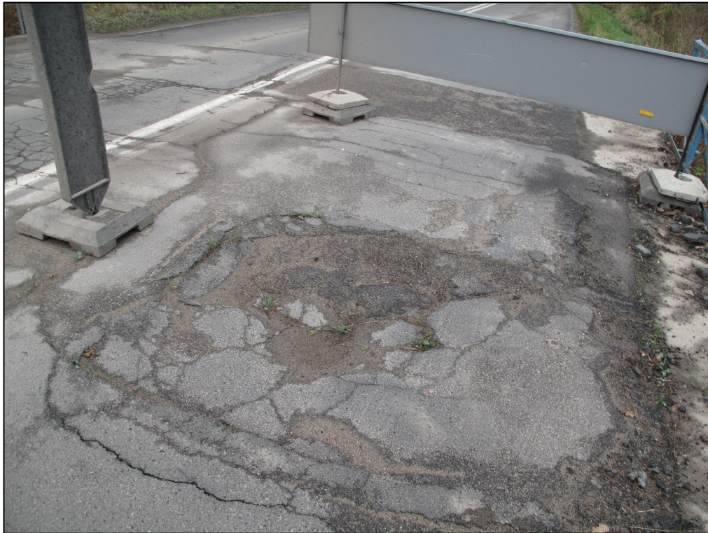
Rys. 4.3. Zabezpieczony fragment uszkodzonej nawierzchni obiektu
