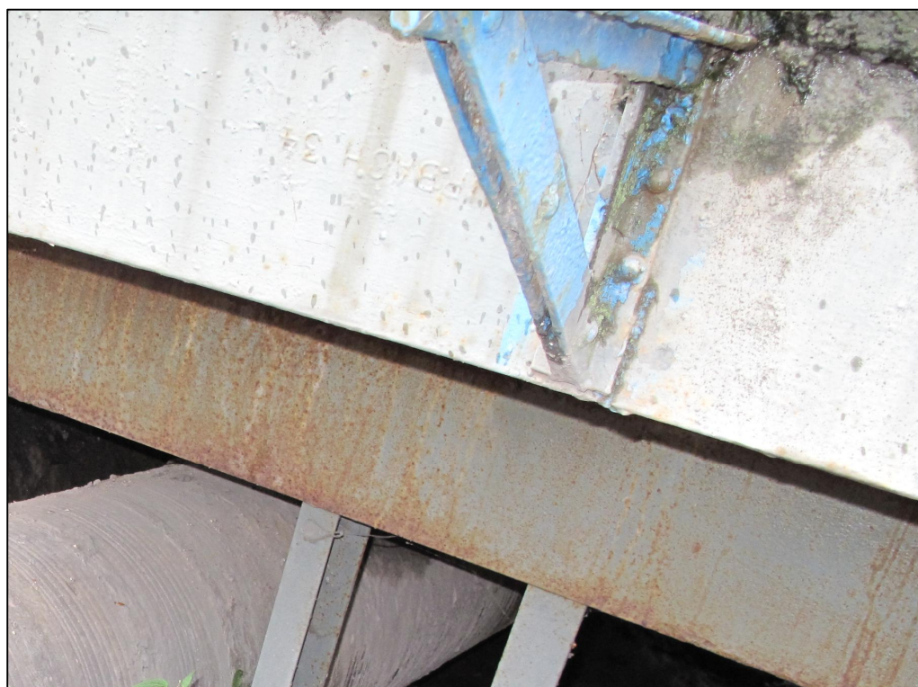
Rys. 4.10. Wysunięte elementy blach pomostu poza obrys obiektu tworzą możliwość oparcia zastrzału dla balustrad
